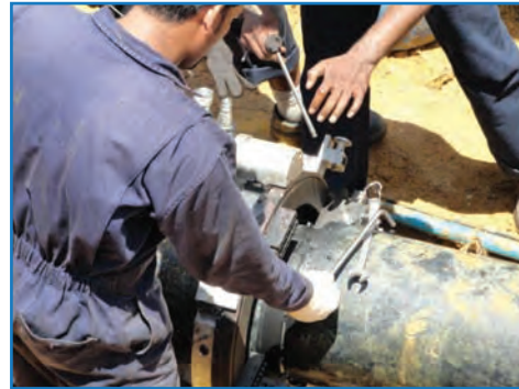
применение трубореза DLW на газопроводах
